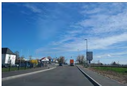
Köstener Straße/Coburger Straße
