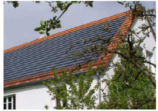
Dach mit Solarziegeln oder versenkten Flachkollektoren eindecken
