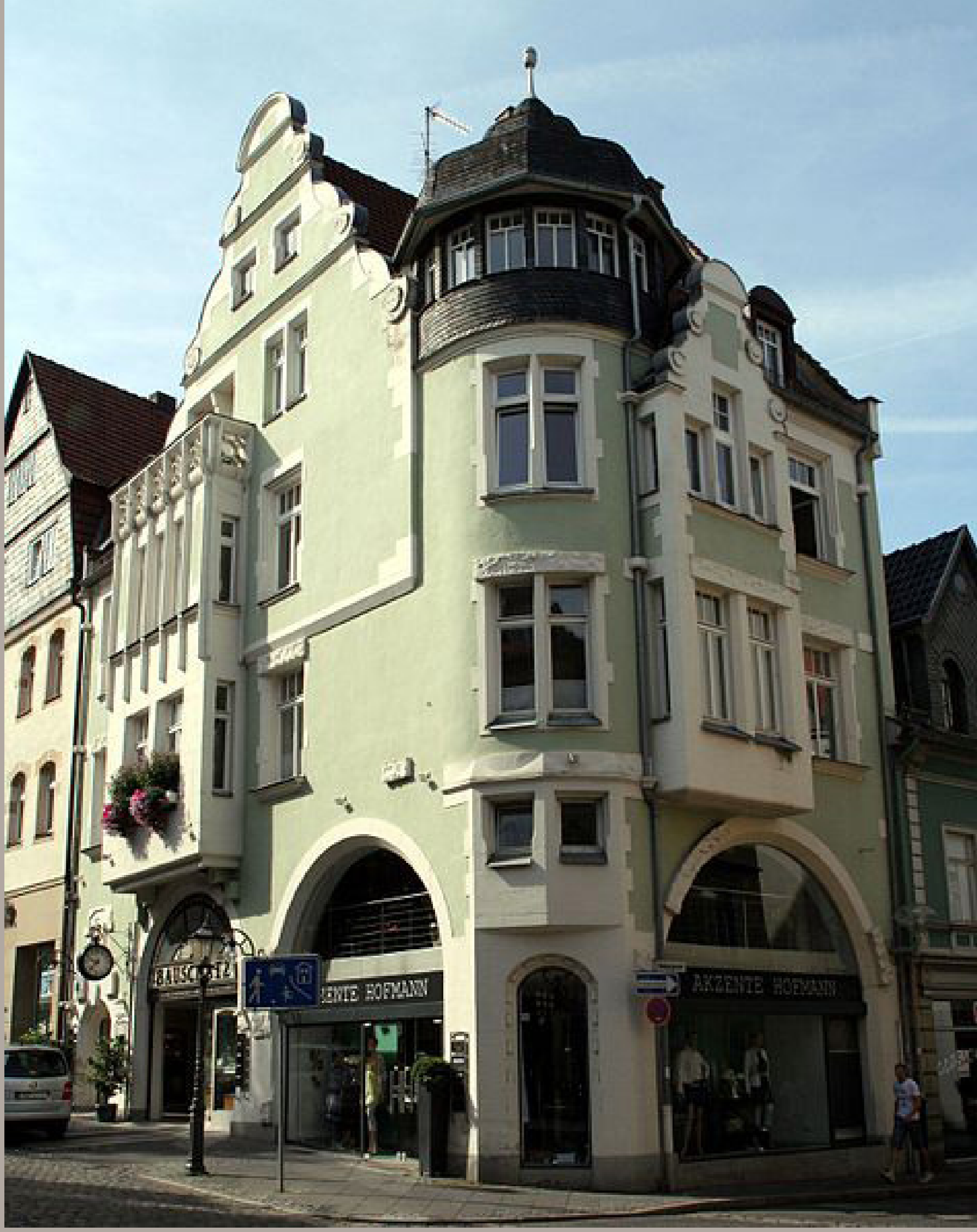
Geschäftshaus in der Mohrenstraße 36
