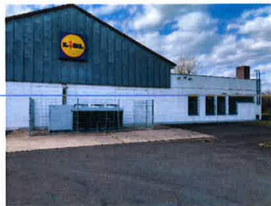
Rückseite Marktgebäude mit Anbau
