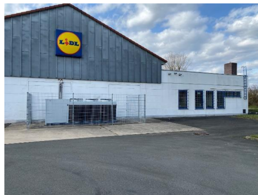
Rückseite Marktgebäude mit Anbau
